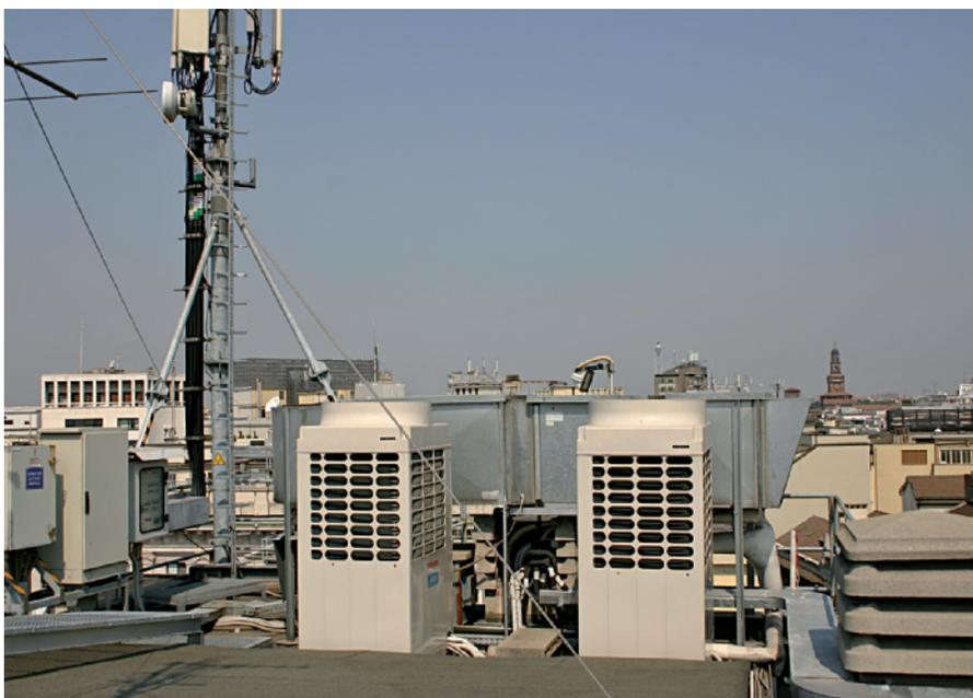
4 Le quattro unità esterne da 33,5 kW di capacità frigorifera occupano una superficie in pianta di un metro quadrato cadauna e sono state posizionate in copertura.
